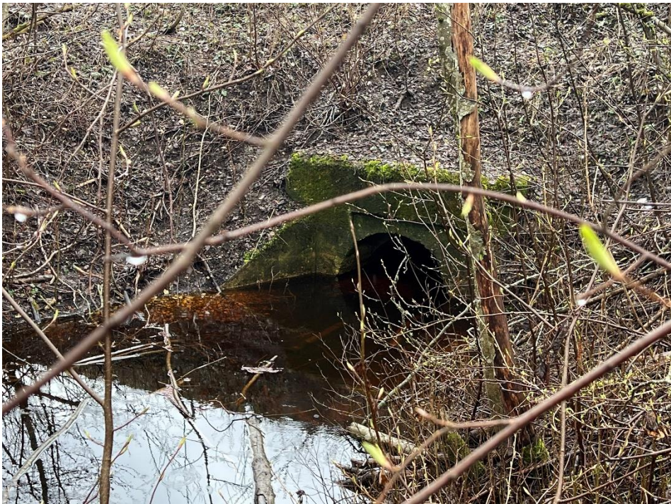
Pilt 1. Heas seisukorras maanteetruup D1000 ( pilt E.K 09.04.2024)
